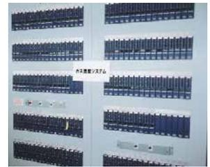
KU-7R 数点以上をパネルに取付した自立型ガス警報盤の設計、製造も行います。
